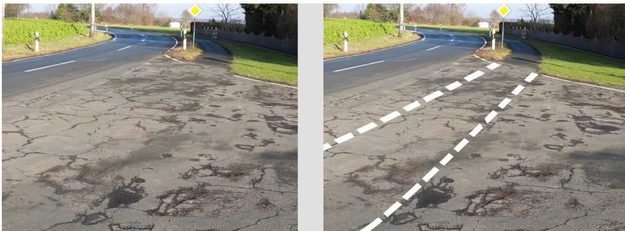
links: IST-Zustand an fast allen Einmündungen der K 122: Furten fehlen
